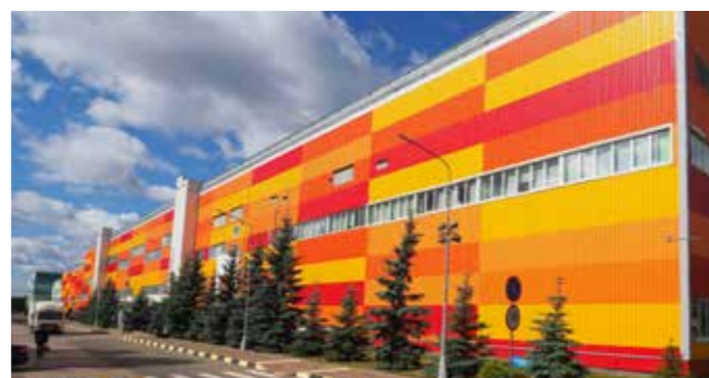
Завод по производству вакцины, ОЭЗ «Технополис «Москва»», Год оснащения: 2020
