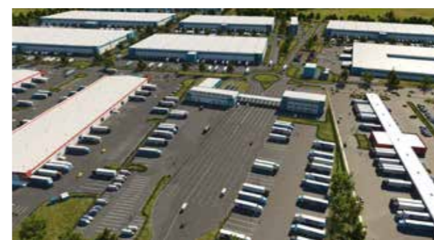
Оптово-распределительный центр «РусАгроМаркет» Новосибирская область Год оснащения: 2020
