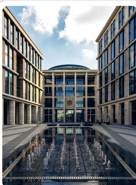
БЦ «НЕВСКАЯ РАТУША», Г. САНКТ-ПЕТЕРБУРГ
