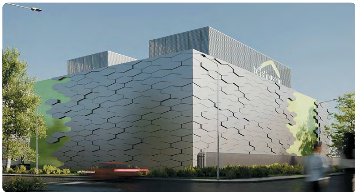
ЦОД «МАГИСТРАЛЬНЫЙ» DATAHOUSE
