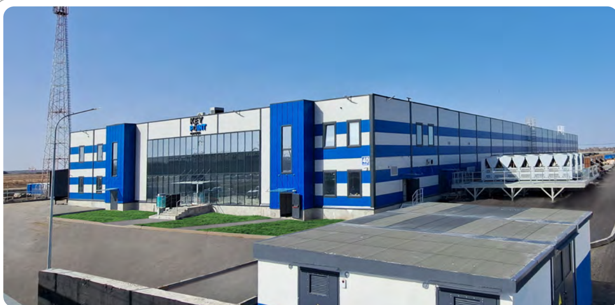
ЦОД ГК KEY POINT Новосибирская область
